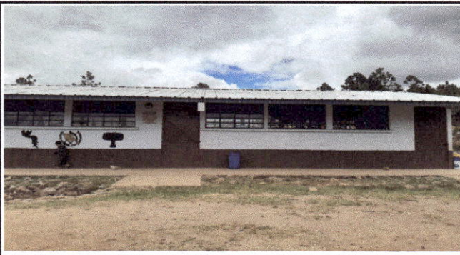
Foto 3: Sustitución de puertas para aula.
