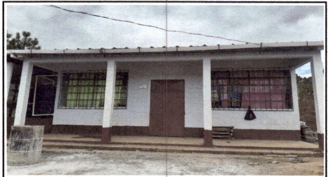
Foto 4: Sustitución de puerta para aula.
