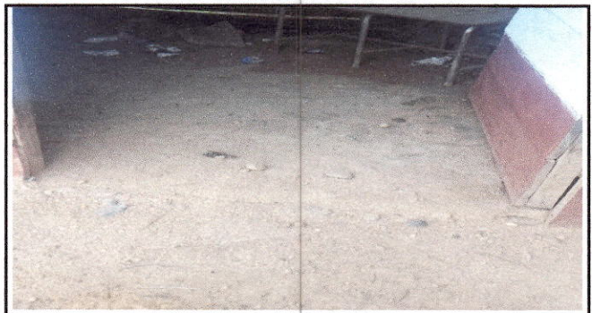
Foto 6: sustitución de piso líquido de cemento
