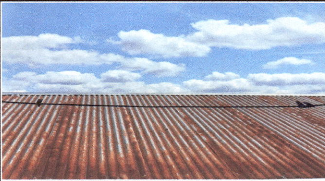
Foto 1: Sustitución de lámina, por lámina troquelada.
